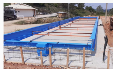
Estruturação das Vigas
