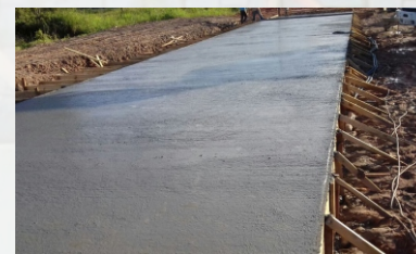
Concretagem Base
