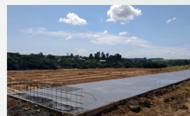
Concretagem da Pista
