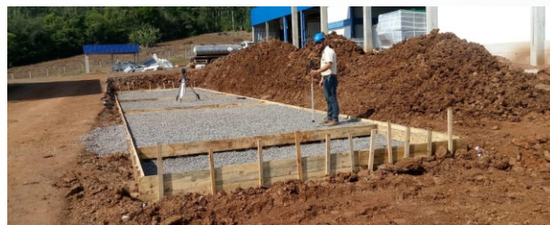
Nivelamento a laser. Equipamentos de precisão para um perfeito nivelamento.
